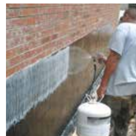
Om schuimplaten snel en gemakkelijk te installeren, hoeft u alleen 3M™ HoldFast 70 Cilinderlijmspray erop te spuiten. Hecht schuim aan beton, waterafdichting, OSB en meer zonder het schuim te beschadigen.
